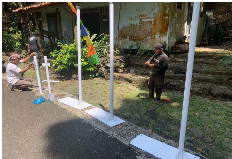
Gambar 7. Pembuatan alat taman bermain dan tiang
