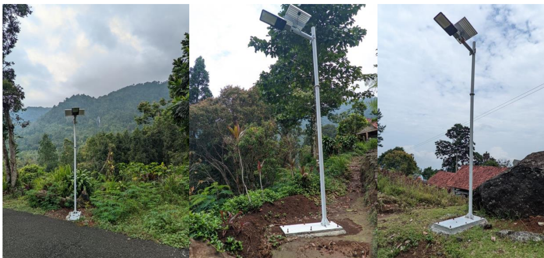
Gambar 9. Pemasangan Solar Panel di setiap sudut wisata
