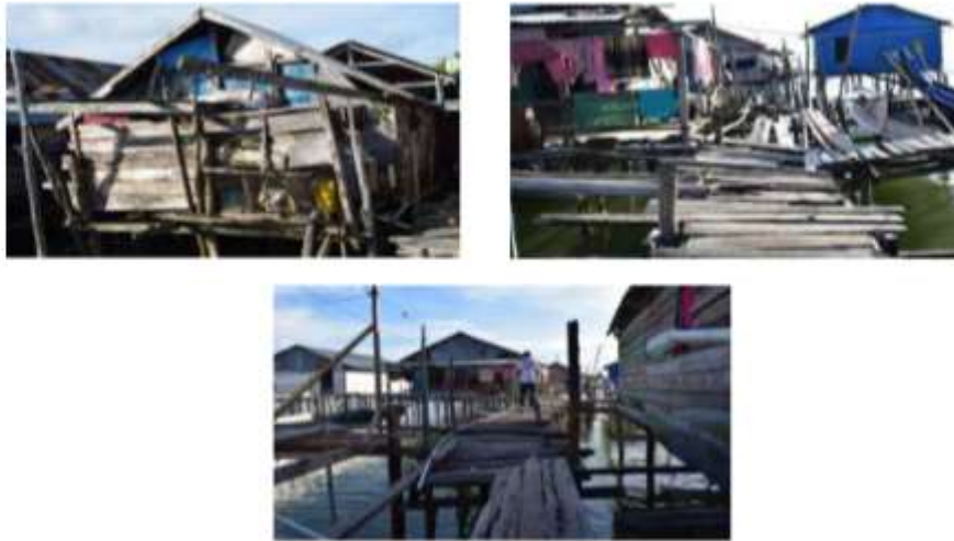
Gambar 1 Kondisi Pemukiman Suku Bajo Anawoi Kabupaten Kolaka
