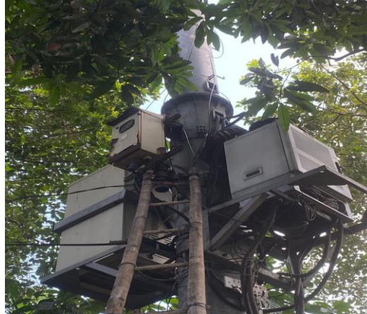
Gambar 5. Pergantian KWH Meter Manual Menjadi KWH Meter AMR TGR 31 (Sumber: Dokumentasi Pribadi)
